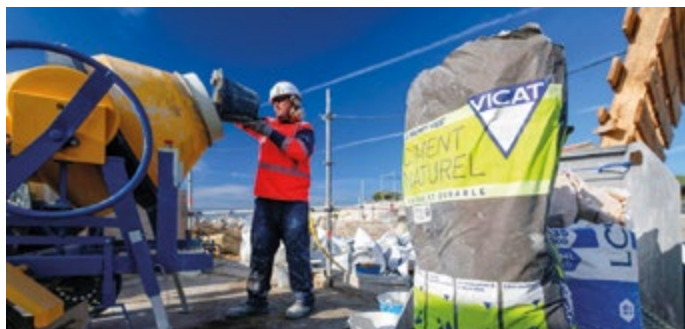
▲ Chantier du château d'If à Marseille (France).
