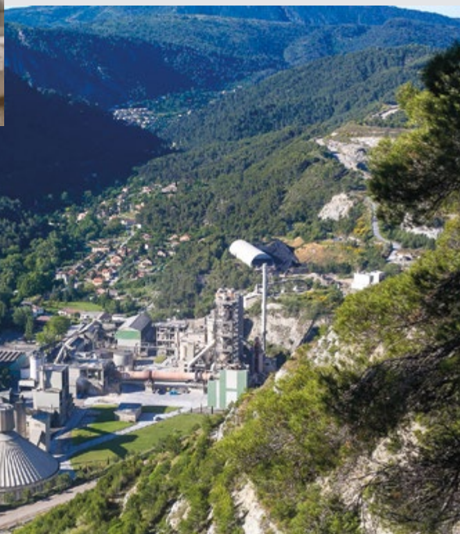
▼ Cimenterie de La Grave-de-Peille (France).
