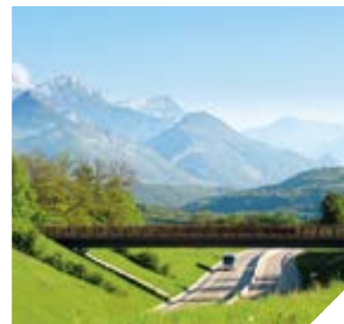
— Pont de la Chabotte réalisé en béton fibré ultra haute performance SMART UP en Isère (France).
