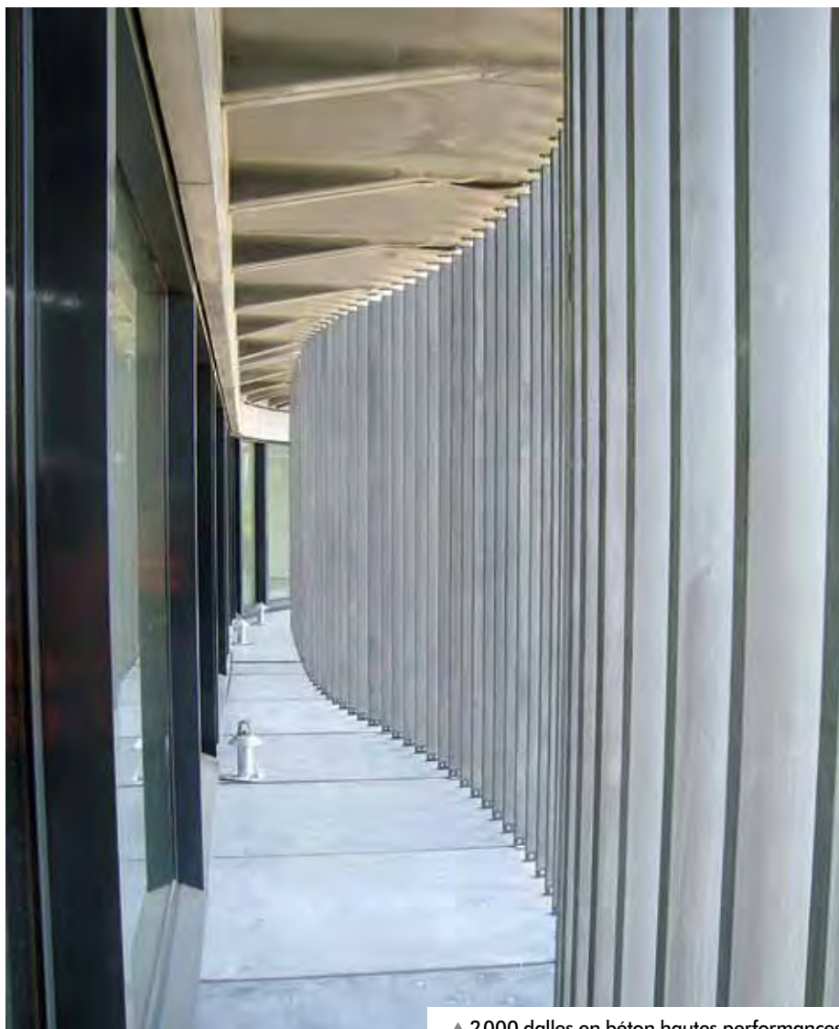
▲ 2000 dalles en béton hautes performances de 100 dimensions différentes constituent l'imposante façade de 2500 m 2 du bâtiment administratif d'Iter à Cadarache (France).
