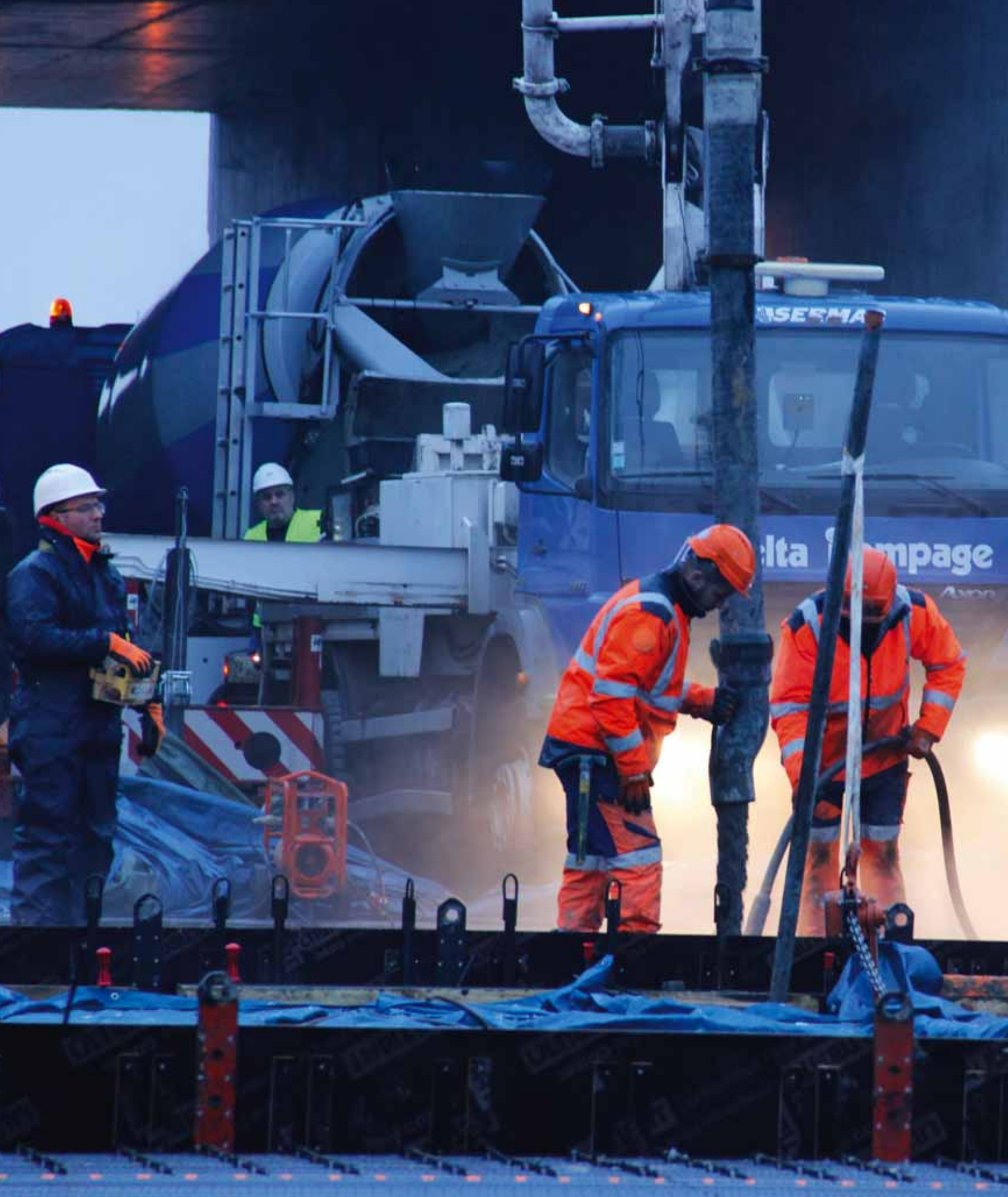
Mise en œuvre de béton prêt à l'emploi avec Delta Pompage, France
