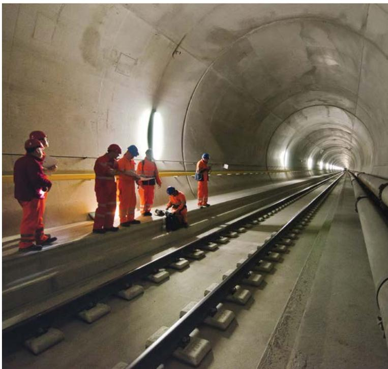
Voie sans ballast système LVT dans le tunnel de base du Gothard.
