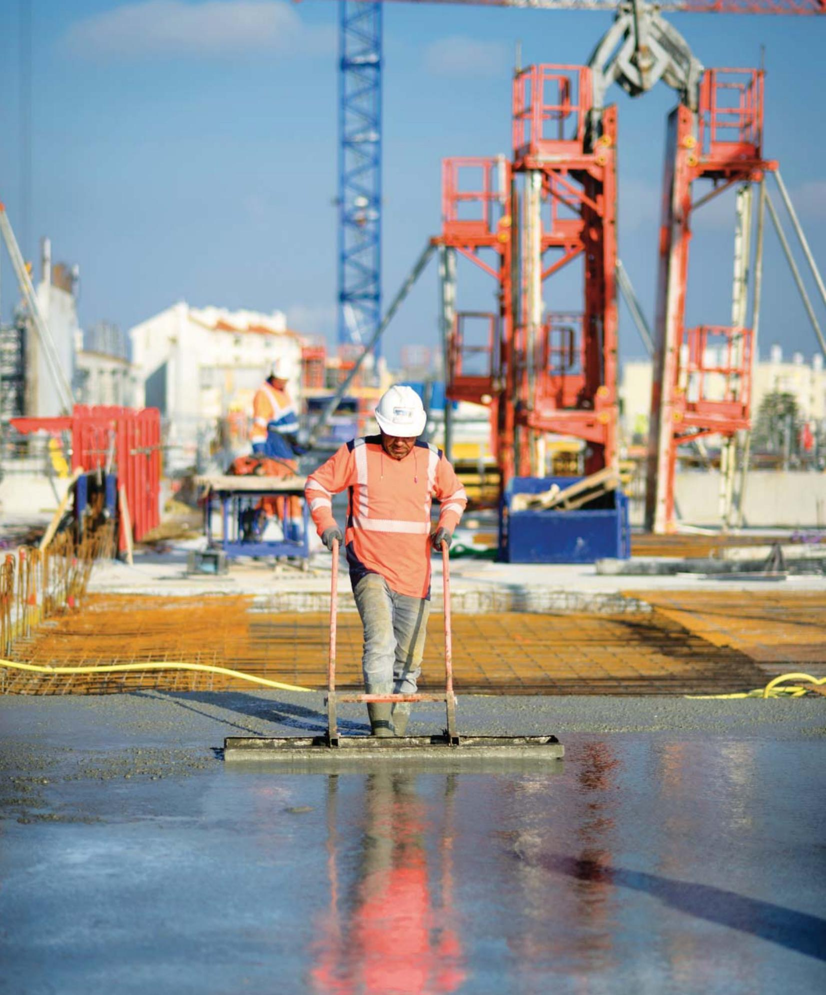
*Finition d'une dalle béton sur le chantier Medipôle à Lyon, France*
