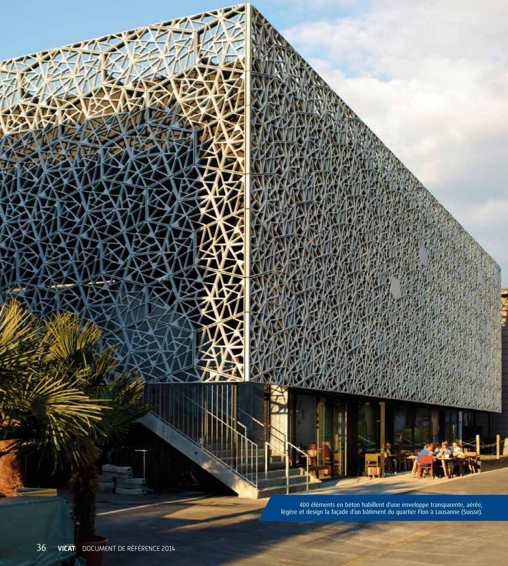
400 éléments en béton habillent d'une enveloppe transparente, aérée, légère et design la façade d'un bâtiment du quartier Flon à Lausanne (Suisse).
